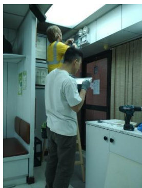
應急照明的安裝及導管佈線
